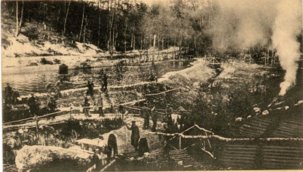
Argonnerwald - Mühle und Schwimmbad
